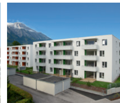
Wohnanlage — Domizil — Hall in Tirol
