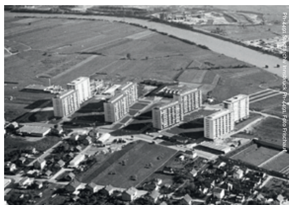
1964 wird der erste Bauabschnitt des Olympischen Dorfes bezogen.
