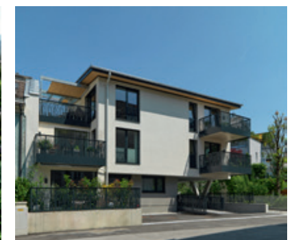
Wohnanlage — VILLA AM BACH — Hall in Tirol
